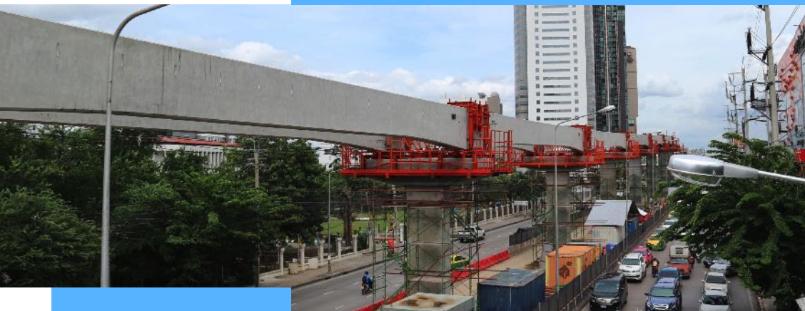
Строительство монорельсовой линии в Бангкоке (фото предоставлено BTS Group).
