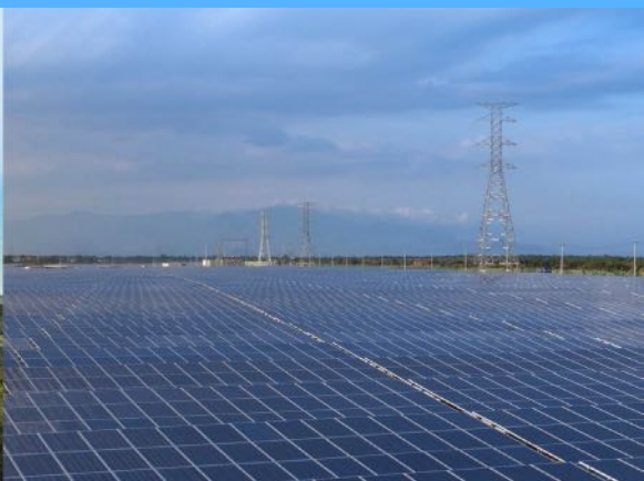
Ветровые и солнечные установки в Филиппинах (ВЭС) и Вьетнаме (СЭС) (фото предоставлены «АС Energy»).
